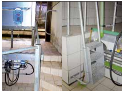
Échelle verticale non glissante (à droite).
